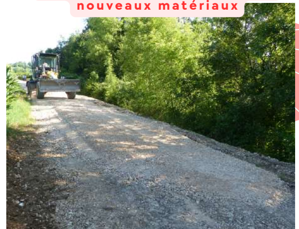
Empierrement et réglage des nouveaux matériaux
