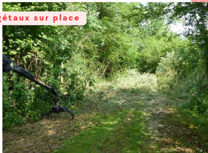
Travaux de débroussaillage mécanique (broyeur forestier monté sur une pelle)
